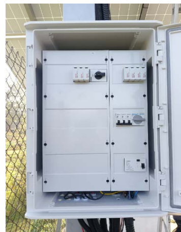
Slika 8. Izgled razvodnog ormana FNE bazne stanice
