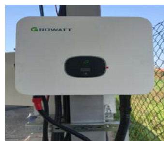
Slika 9. Prikaz montaže GROWAT invertora 8kW
