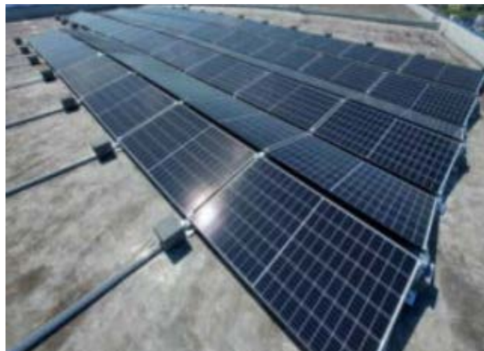
Slika 2. Način montaže fotonaponskih modula [4]
