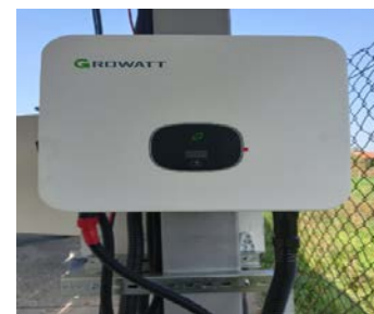
Slika 9. Prikaz montaže GROWAT invertora 8kW
