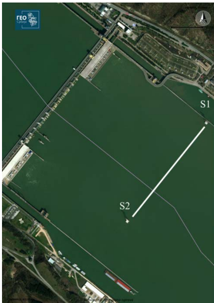
Slika 2. Položaj dalekovoda DV405 nizvodno od brane Đerdap 1 (Izvor: Geosrbija https://a3.geosrbija.rs/ )
