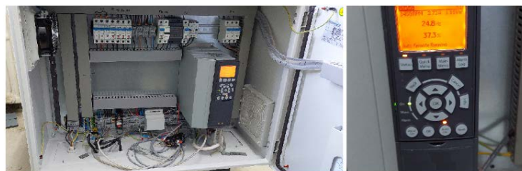
Slika 7. Detaljan prikaz unutrašnjosti GRO sa prikazom displeja frekventnog regulatora u režimu 1459 o/min i pri izlaznoj snazi 1.1 kW
