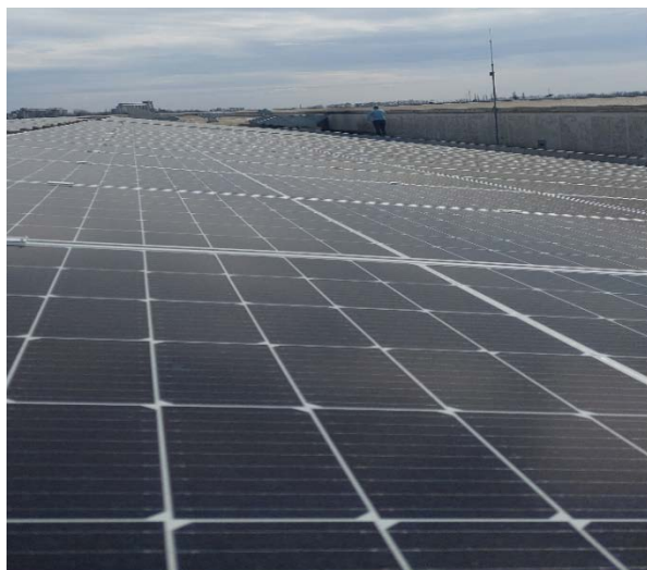
Slika 23. Raspored solarnih panela na ravnom delu krova
