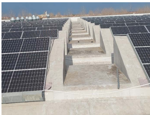
Slika 23. Raspored solarnih panela na ravnom delu krova
