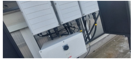
Slika 26. Prikaz invertorske grupe SolarEdge 2x100kW
