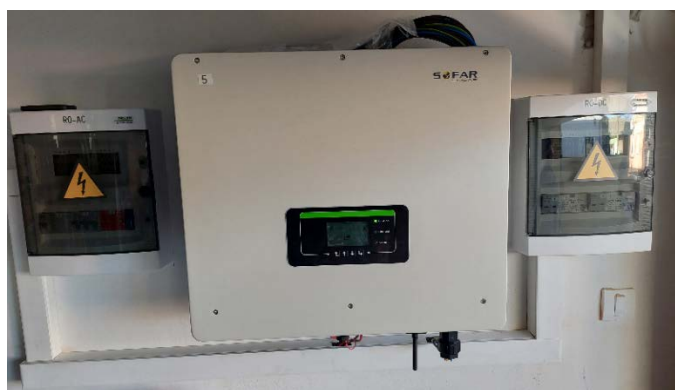
Slika 9. Slika solarne elektrane
