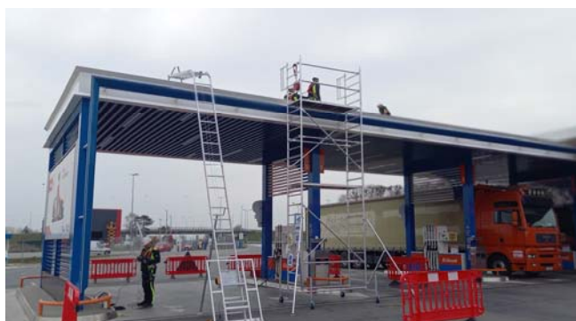
Slika 11. Izvođenje radova na SSG
