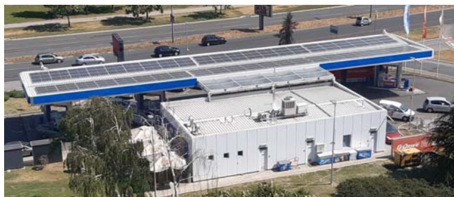
Slika 6. Pozicija FN panela na nadstrešnici iznad točionih mesta
