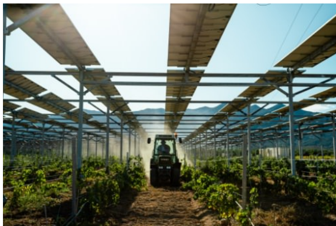
Slika 3. APV sistem sa visokom montažnom konstrukcijom
