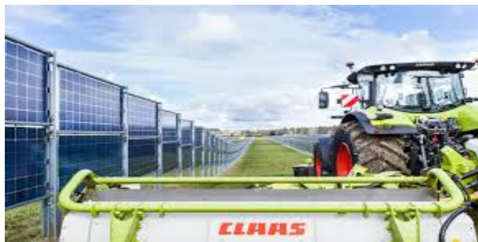
Slika 2. APV sistem sa vertikalnim panelima
