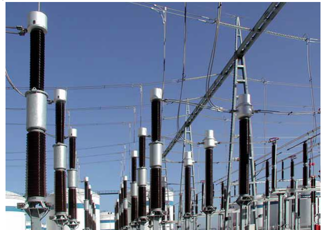
Slika 2. Induktivni naponski merni transformatori za najviši napon 420 kV [6]
